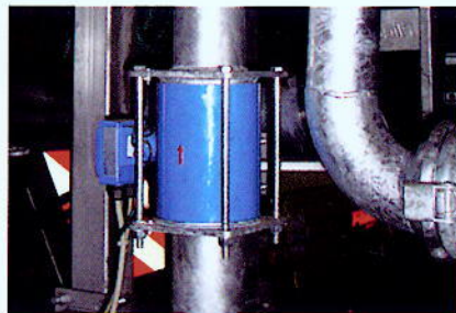
elektronický průtokoměr.
